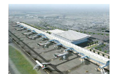
T3 - Dubaï Terminal 3 in Dubaï Airport (Laing O'Rourke JV - Dubaï)
